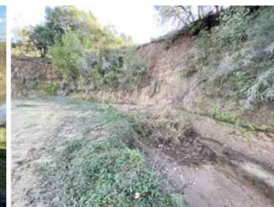
*Km 36:* Se registró un derrumbe y embanque en el bypass del túnel, abarcando aproximadamente 80 mts.
