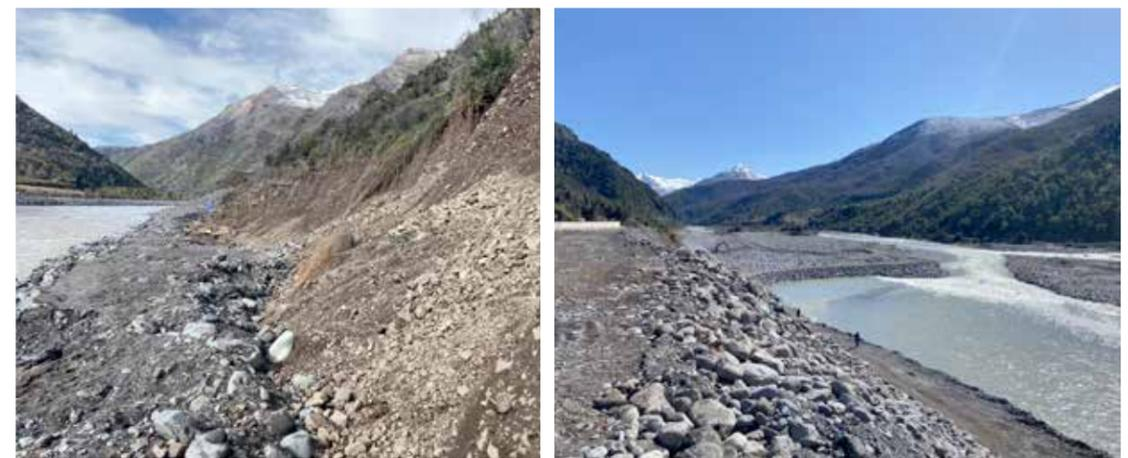
*Alimentador El Toro: derrumbe de rocas que destruyó el canal (no rehabilitado).*
