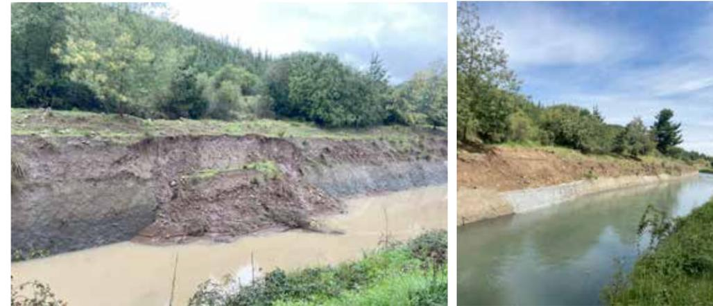
**Km 4:** Derrumbe de cerro con destrucción de 60 mt. de muro revestido.
