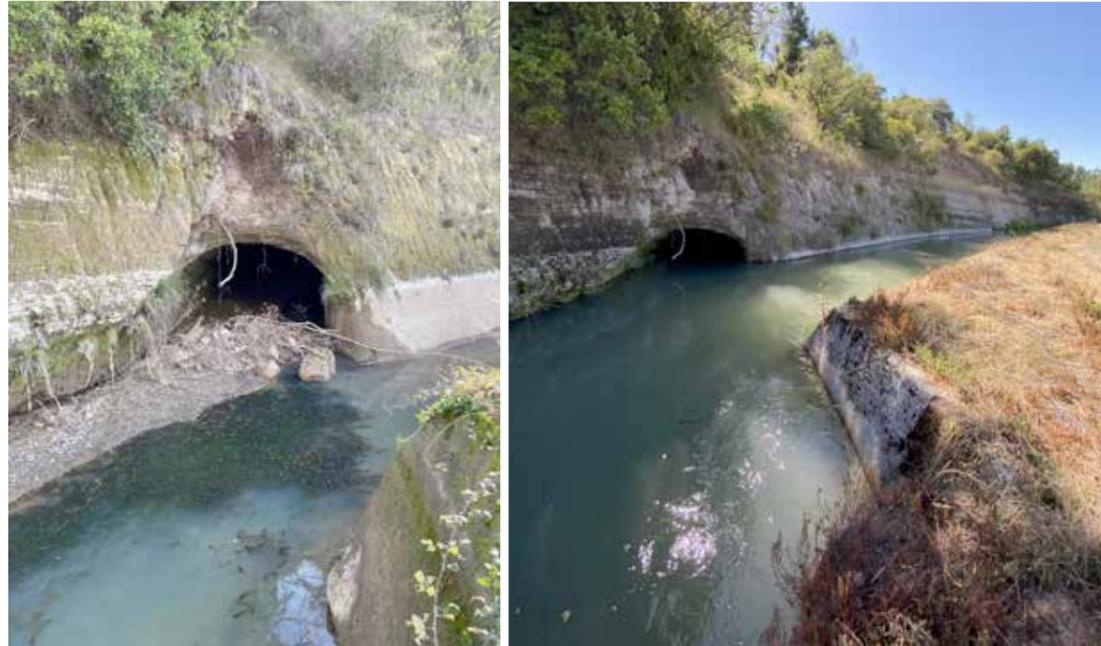
*Km 40:* Sifón Las Toscas: Daños estructurales en los muros del sifón, tanto al ingreso como a la salida de este.
