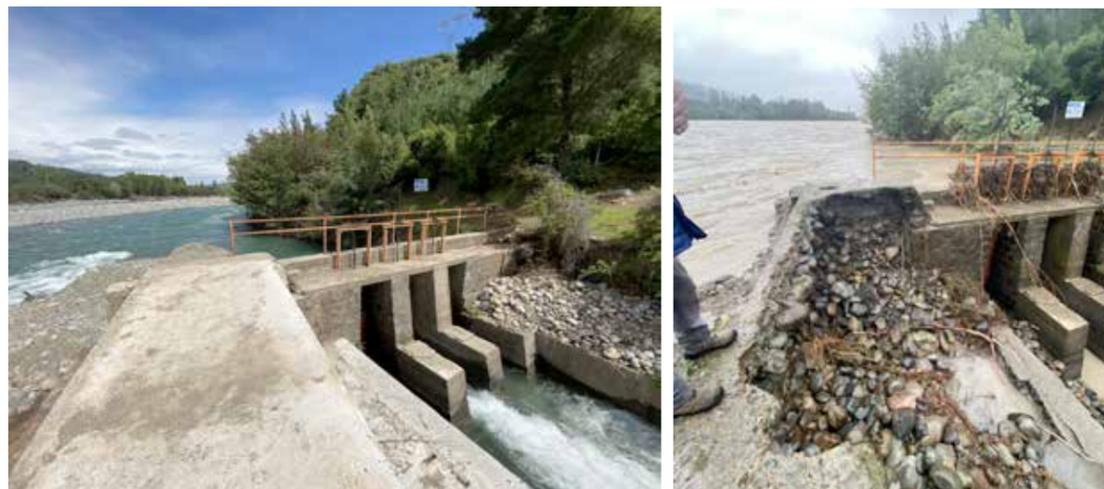
**Km 3:** Derrumbe con rotura de un muro de hormigón con una longitud de 20 mt.
