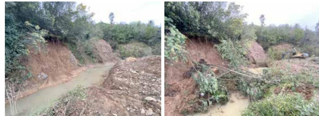
*Km 8-9:* Tramo del canal borrado, debido al ingreso del río Achibueno, abarcando aproximadamente 700 metros. Se reconstruyó el talud de los muros y el camino de borde.
