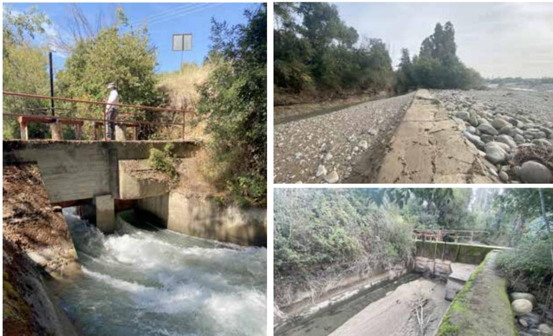
**Km 0.3:** Se llevó a cabo un relleno con material detrás del muro que alberga las compuertas de descarga. Este relleno, con dimensiones de 6 x 3 x 4 metros, fue necesario debido al lavado de tierra en la zona.
