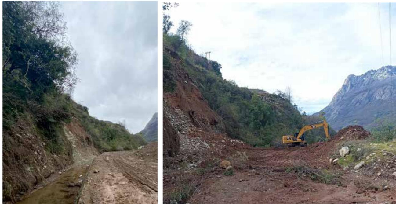
*Km 3.3- 5.4: Rotura de muro y derrumbes.*
