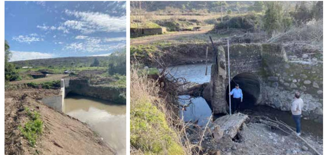
*Km 45:* Rotura de puente, recanalización de derrames y construcción de puente nuevo.
