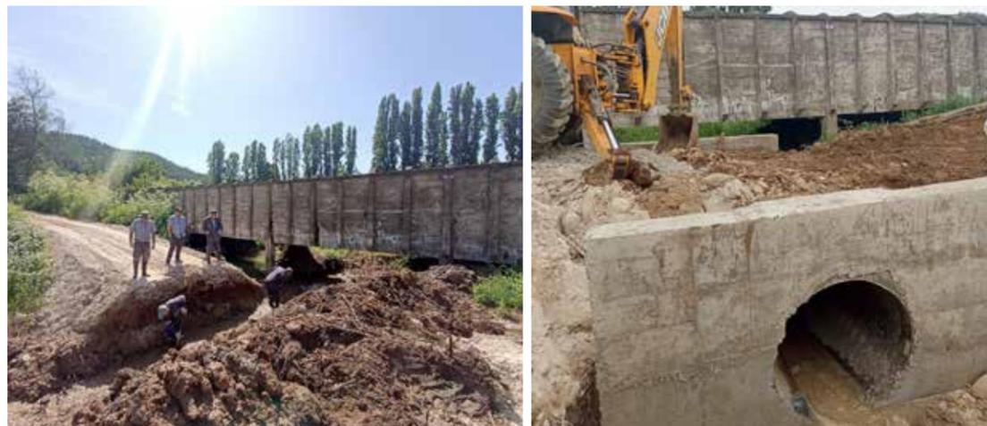
*Km 6:* Derrumbe y caída de puente
